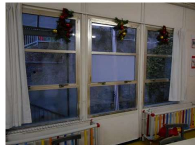
Figura 8.5 - Particolare degli infissi
