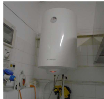
Figura 4.14 - Particolare di un boiler elettrico per la produzione di acqua calda sanitaria
