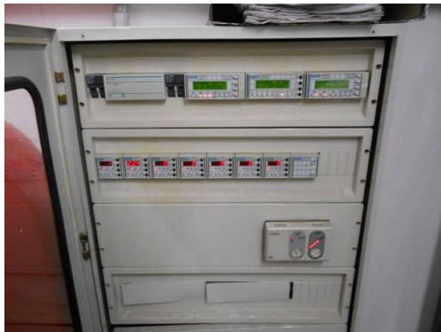
Figura 4.9 - Centralina di controllo dell’edificio
