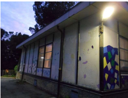
Figura 4.3 – Rilievo termografico della parete
