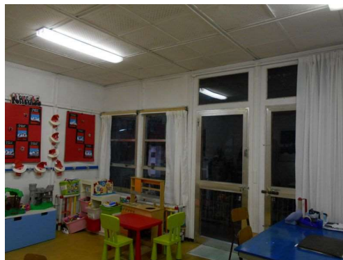
Figura 8.10 - Particolare di una plafoniera a tubi fluorescenti
