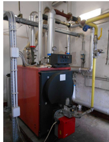
Figura 4.13 - Particolare delle caldaie
