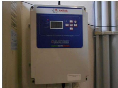
Figura 4.10 – Dispositivi per la telegestione
