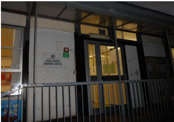
Figura 4.1 - Particolare della facciata principale
