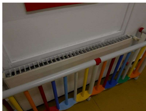
Figura 4.8 - Particolare di un radiatore in ghisa
