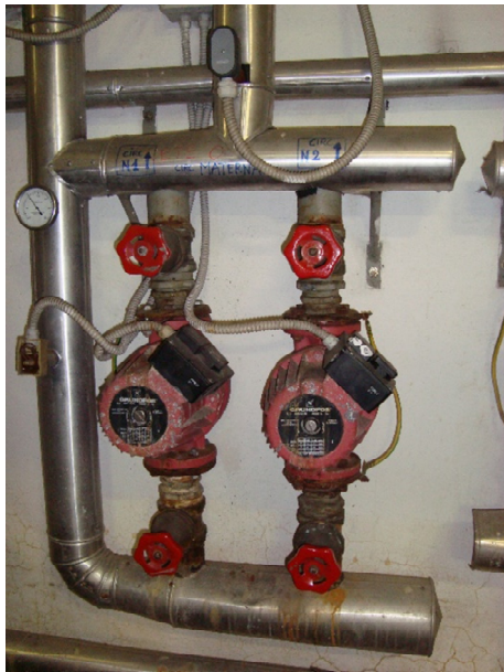
Figura 4.7 - Particolare dello stacco di mandata alla scuola materna
