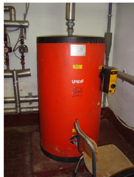
Figura 4.13 - Particolare accumulo ACS
