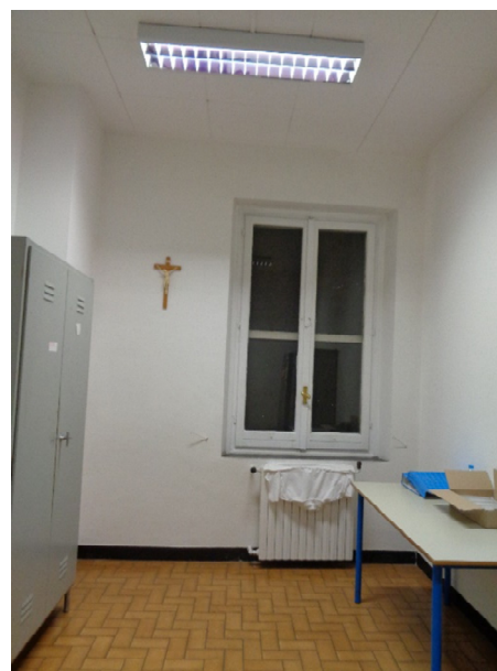
Figura 4.6 - Particolare radiatori su parete interna
