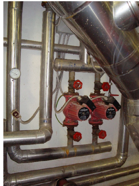
Figura 4.8 – Particolare dello stacco di mandata all'asilo
