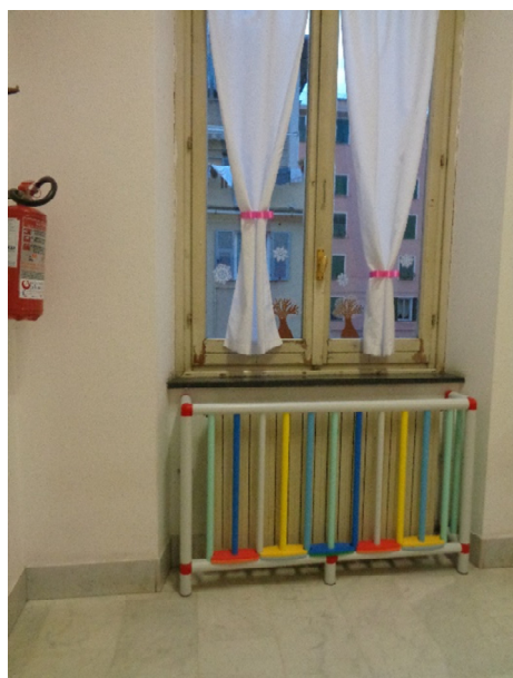
Figura 4.5 – Particolare radiatore su parete interna
