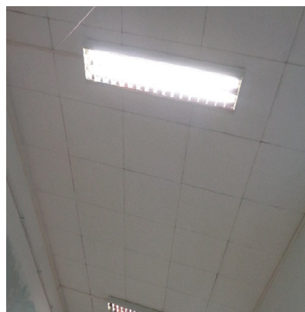
Figura 4.16 - Particolare dei corpi illuminanti ubicati nei corridoi
