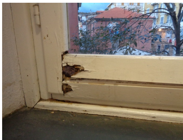
Figura 8.1 – Particolare dei serramenti esistenti
