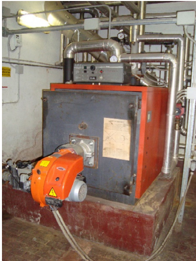
Figura 4.11 - Particolare generatore di calore
