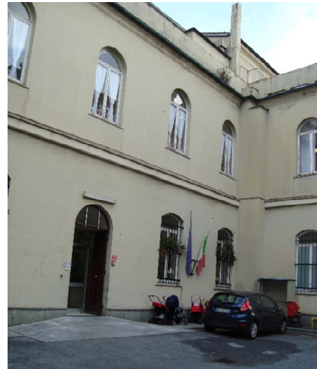
Figura 4.1 - Particolare facciata est fabbricato
