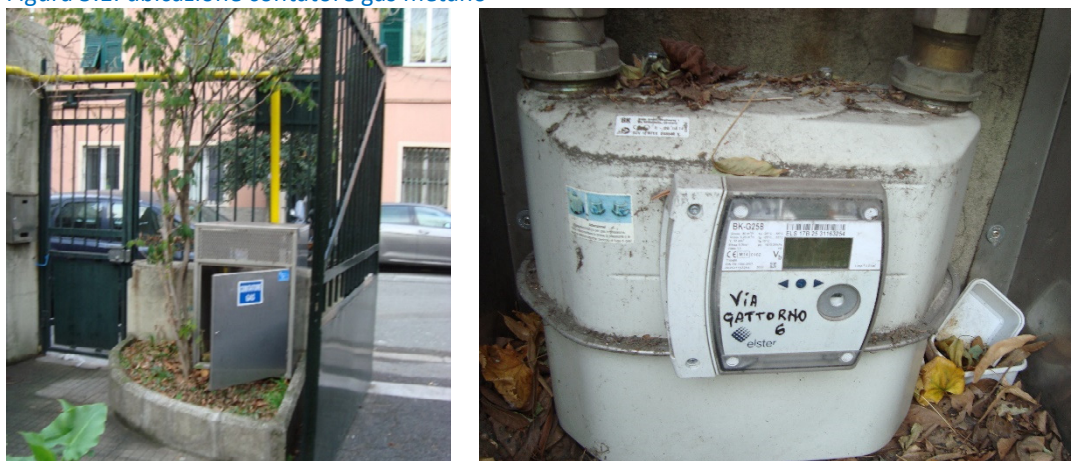
Figura 5.1: ubicazione contatore gas metano
