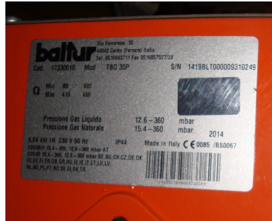
Figura 4.12 - Particolare targhetta bruciatore
